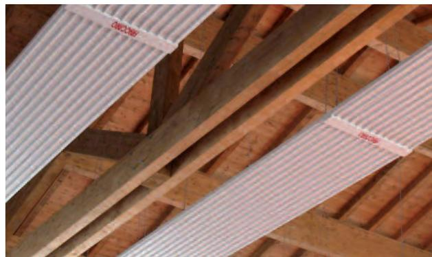
Das geringe Speichervolumen der Deckenstrahlplatten ermöglicht optimale Regelbarkeit. Gleichzeitig sind individuelle Zonenregelungen und abgesenkte Temperaturbereiche möglich.
